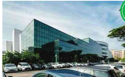
7000 Ang Mo Kio Ave 5 ("7000 AMK")
